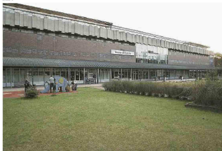
La facciata dello stabilimento termale
